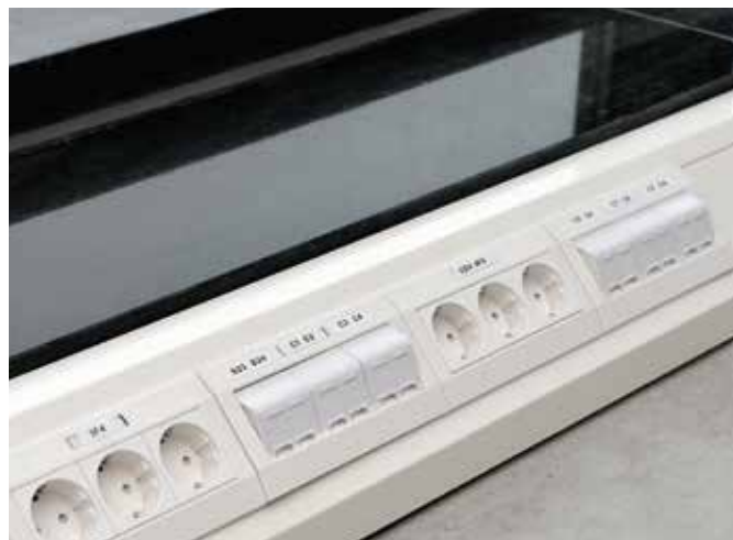
Der Pultkanal sorgt im Neubau der REWOTEC-Gruppe für die Versorgung aller Arbeitsplätze mit Elektrizität und Datenverbindungen.
