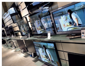
Für die Bildschirm-Präsentationswand wurden drei große Brüstungskanäle übereinander montiert.
