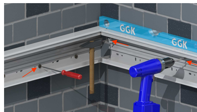
Montage des Kanalunterteils
